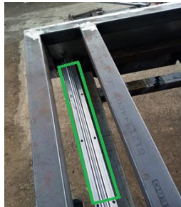
Figura 12. Construcción de las guías cilíndricas
