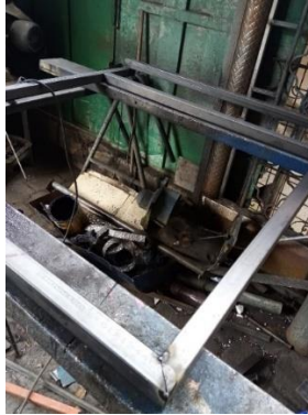
Figura 11. Construcción de la estructura base.
